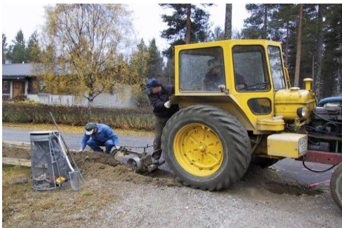
Kabelförlägningsdjup
